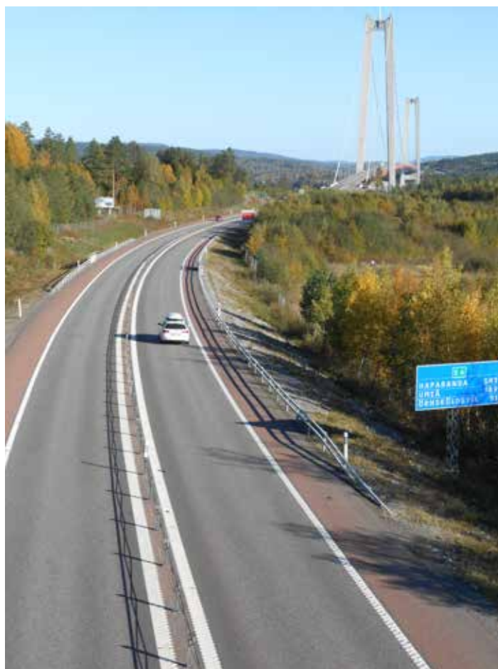
Foto. 20: E4 och Høga Kustenbron från vägbro (Rv90).
