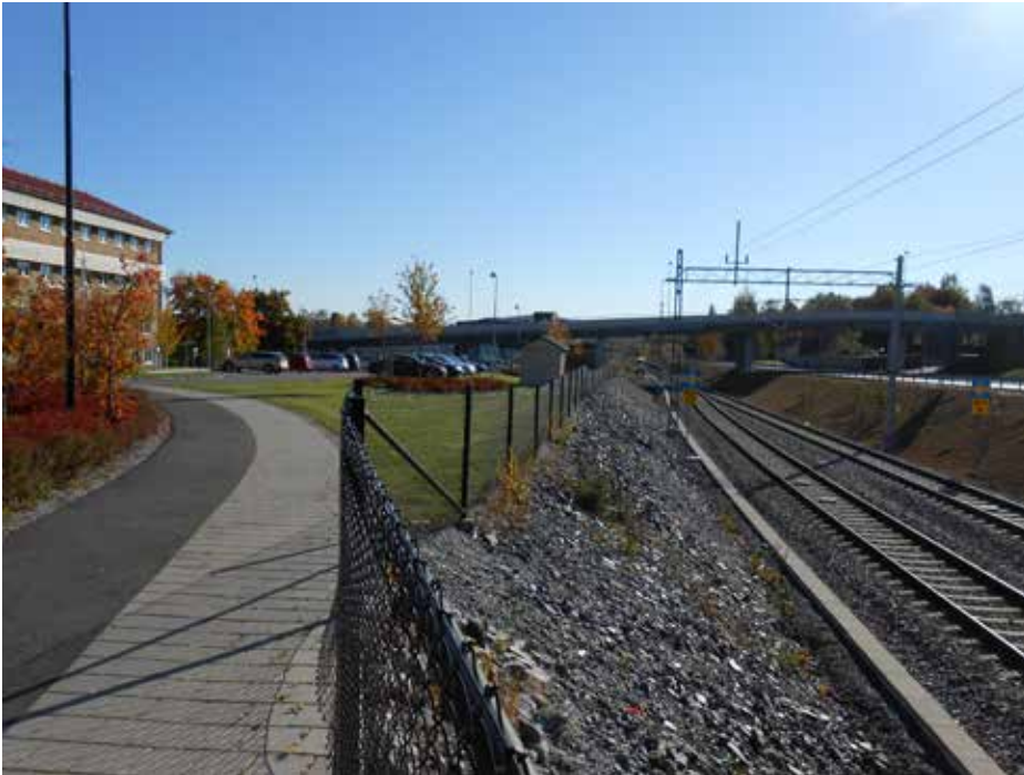
Foto. 11: Vid en förlängning av plattformen i Kramfors behöver viss yta tas i anspråk. Det är främst ytan som utgörs av stenkross i slänt samt ett par meter till vänster om stationen. Det behöver anslutas ramper och trappor samt att ett plattformstak behöver byggas. Foto mot söder.
