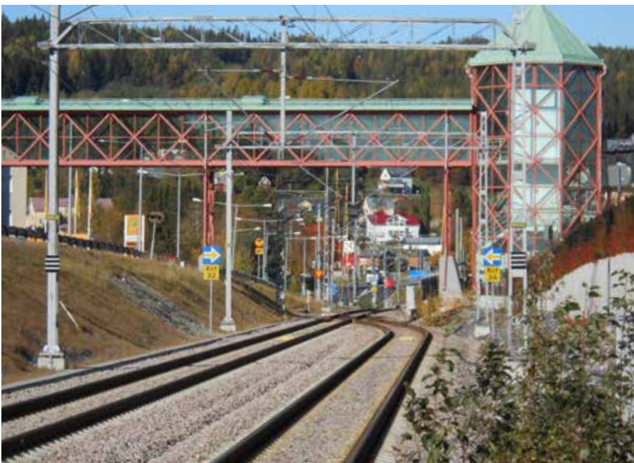
Foto. 13: Bilden visar den befintliga gångöverfarten som sträcker sig över såväl väg som järnväg.
