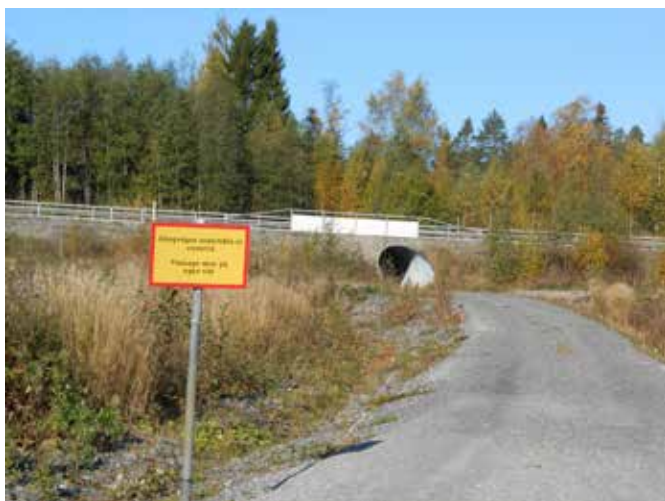
Foto. 18: Gång- och cykeltunnel under E4
