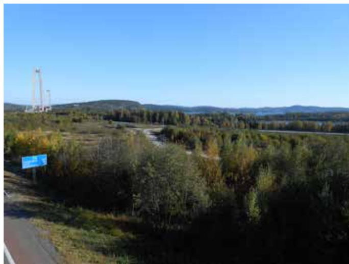
Foto. 19: Stationsområdet anas i fotot, det går att se kontaktledningstolpar och befintliga tillfartsvägar.
