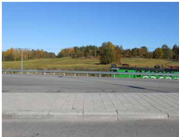
Foto. 17: Höjdskillnaden mellan busstjänst/hållplatsen och spåret är ca 2 meter och delar av stationen behöver sänkas för att ge utrymme för plattform och väderskydd. Godståget i bilden visar storleken på skärningen i marken.
